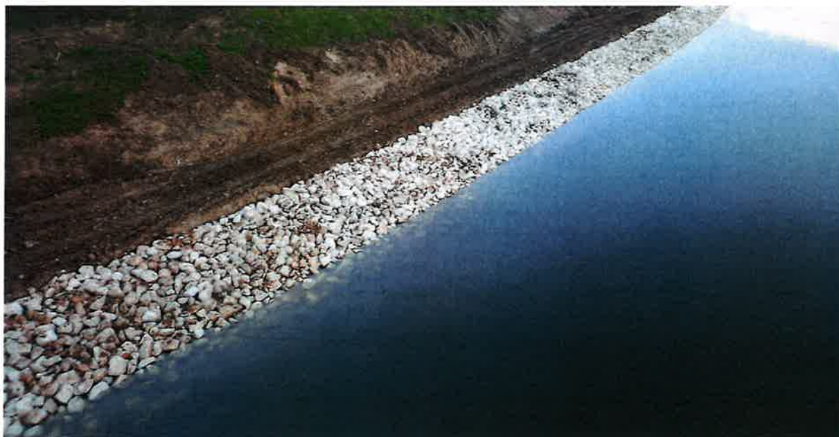
Figura 7 – Esempio rivestimento di sponda in pietrame sciolto realizzato nel medesimo canale.
