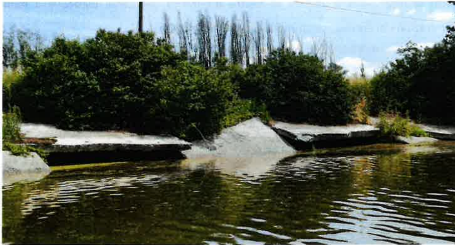
Figura 5 – Rivestimento di sponda fortemente ammalorato.
