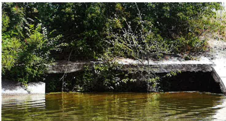
Figura 6 – Erosione del corpo arginale.
